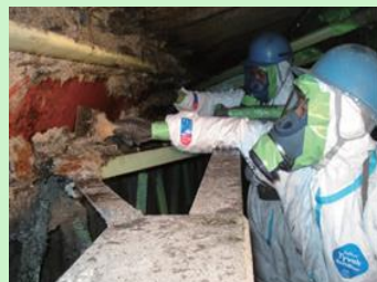
吹付け石綿の除去作業の様子
